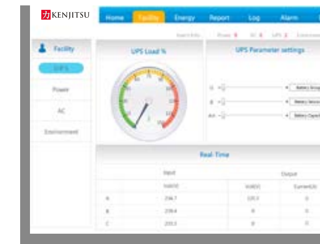
Estado de UPS
